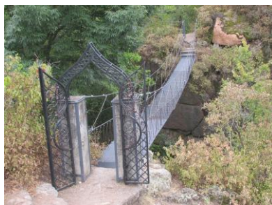
Рис. 10. Підвісний залізний міст
